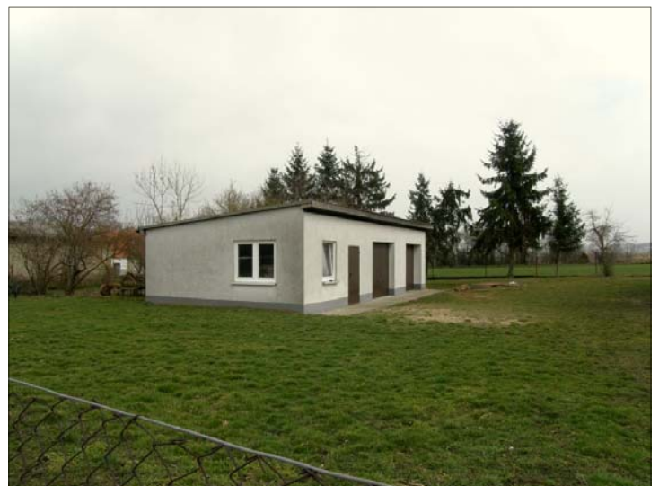
Ansicht Doppelgarage und Mehrzweckgebäude
