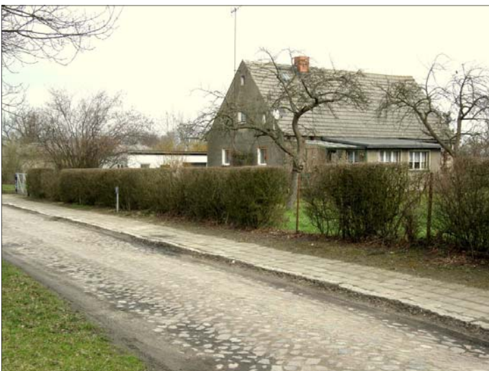
Ansicht Wohnhaus und Straße
