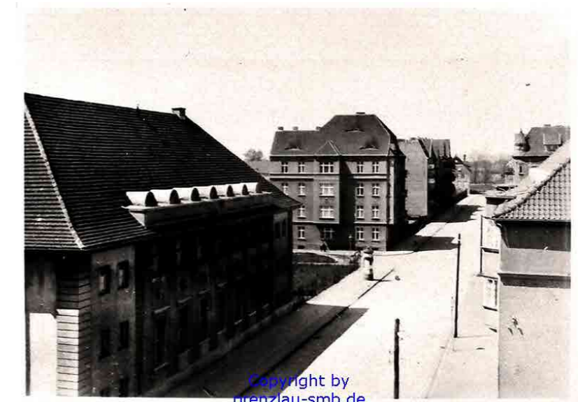
Winterfeldtstraße 1930, Turnhalle Pestalozzischule, Blick auf das Vorhabengrundstück mit Eckbebauung Am Durchbruch
