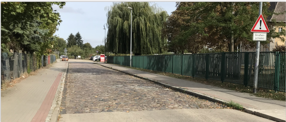
Abbildung 2-6 Am Durchbruch (Blickrichtung Nord)
