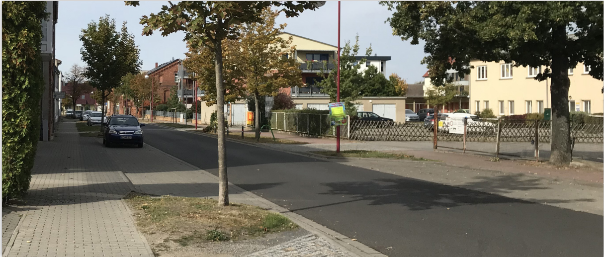
Abbildung 2-4 Kietzstraße (Blickrichtung West)
