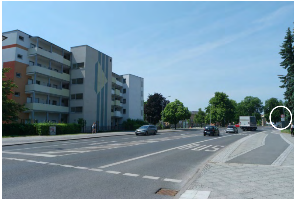
Abbildung 2: Baustraße (Blickrichtung Westen, durch Kreis mit weißem Rand gekennzeichnet: Beschilderung für zul. Höchstgeschwindigkeit 30 km/h nachts für Kfz mit zulGG > 7,5 t)
