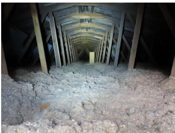
Blick in den Dachboden
