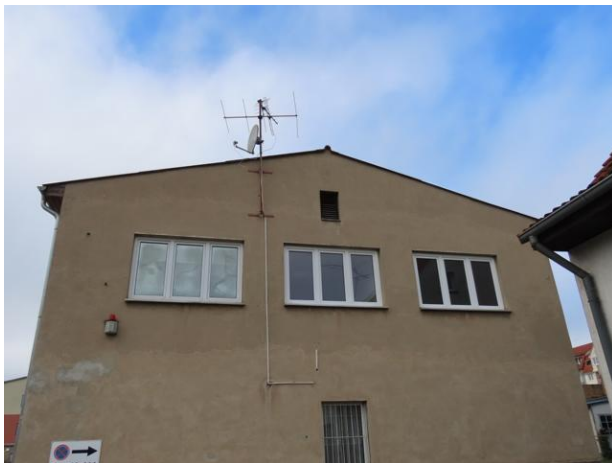
Einstiegs Luke in den Dachboden
