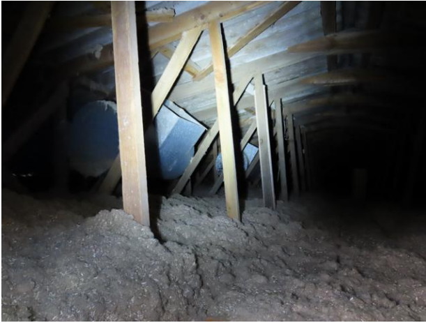
Blick in den Dachboden
