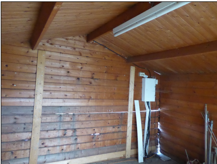
Abb. 13 Gebäude im Plangebiet, kein Vorkommen von Fledermäusen nachweisbar (Mai 2019) (Quelle: Büro Knoblich 2019)
