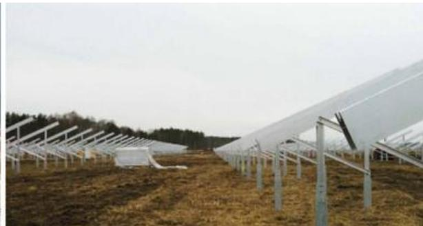
Die Module, die Gleichstrom erzeugen, werden zu Strängen untereinander verkabelt und an die Wechselrichter angeschlossen. Hier findet die Umsetzung des durch die Solarmodule erzeugten Gleichstroms in netzkonformen Wechselstrom statt.
