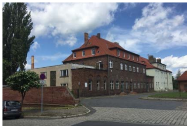
25 Alter Kreisbahnhof, Stettiner Straße 69
